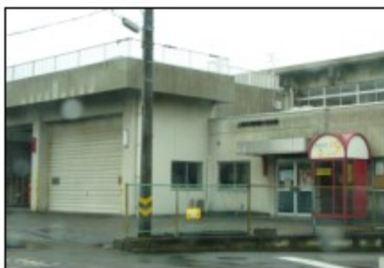
老朽化した消防大石分署
