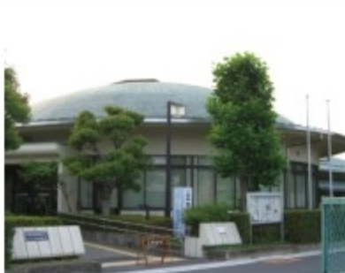
経年劣化の顕著な上平公民館
