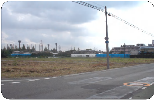
更地となった新図書館複合施設建設予定地
