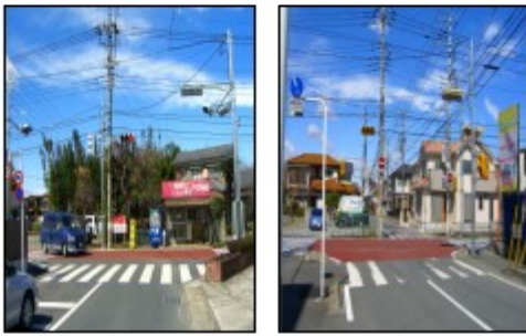
新設された自動点滅式信号機
